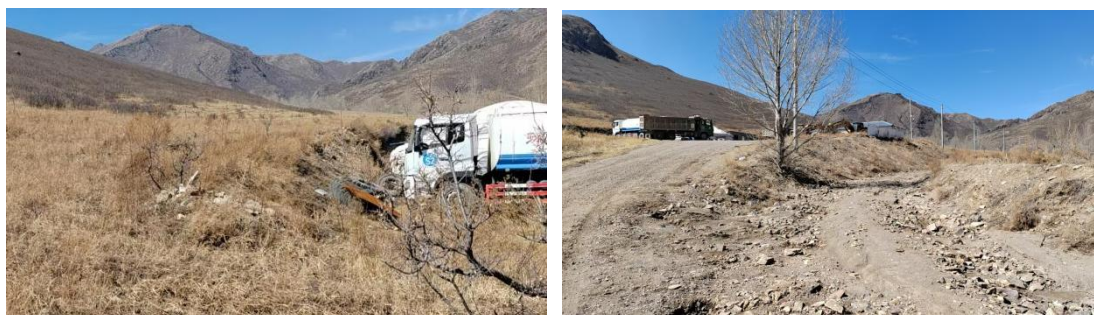
照片 3-21 办公生活区边坡治理效果
