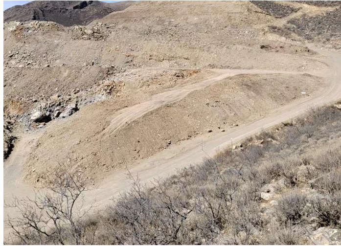
照片 3-22 露天采场界外部分局部治理效果
