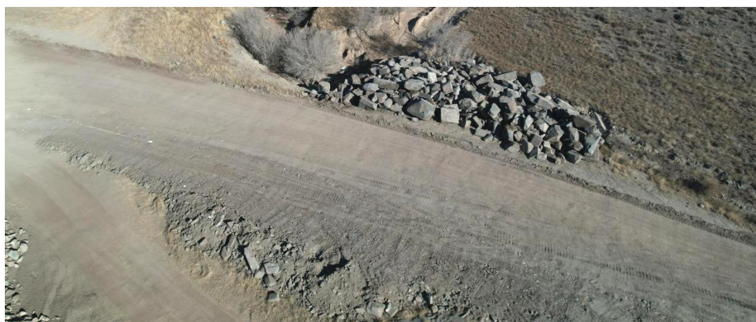
照片 3-14 矿区道路
