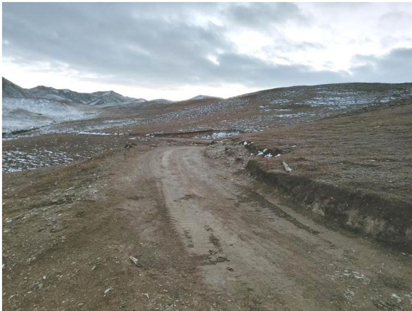
照片 4-6 矿区道路
