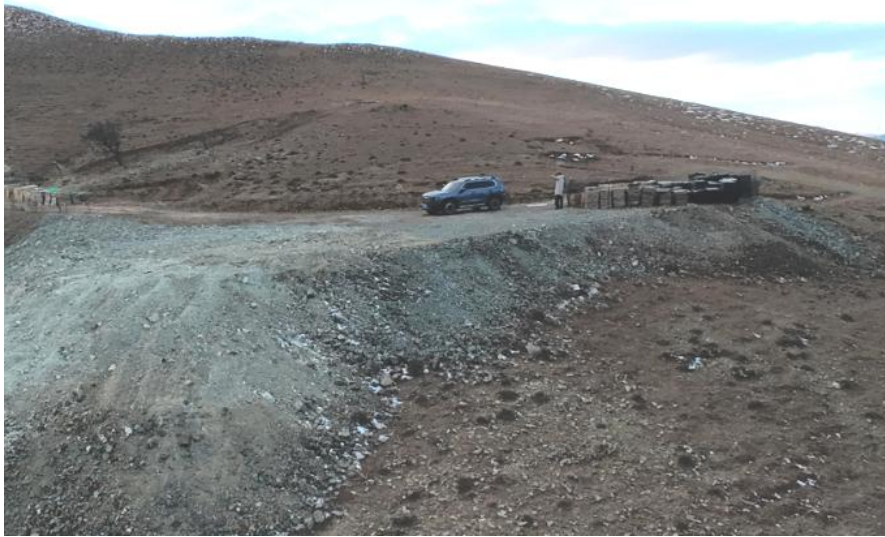
照片 2-1 SJ1 工业场地（井口回填、建筑物拆除）治理效果
