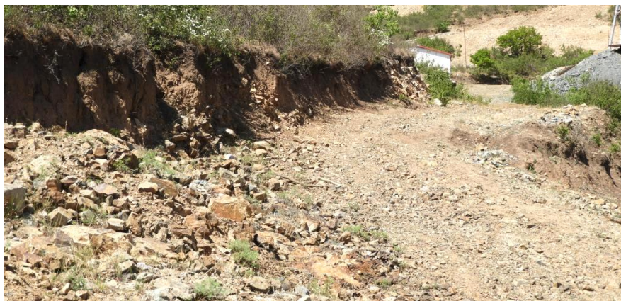
照片 4-18 矿区道路
