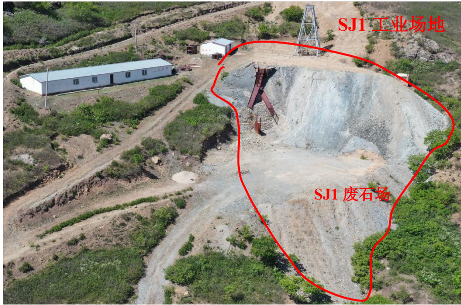
照片 4-8 SJ1 废石场全景
