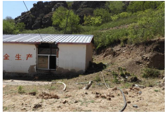
场地内建筑及切坡
