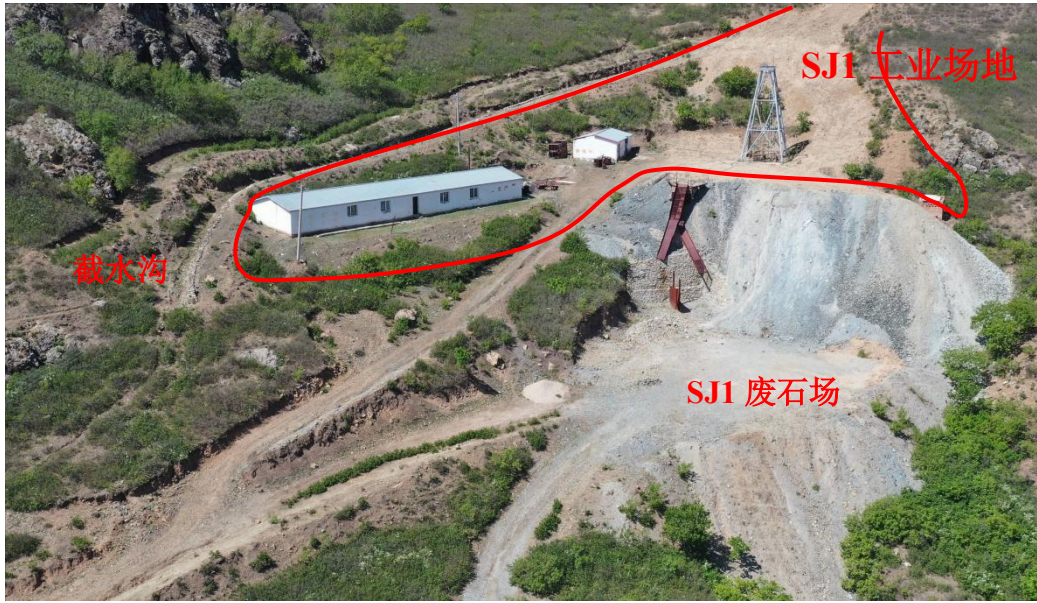
照片 4-1 SJ1 工业场地全景
