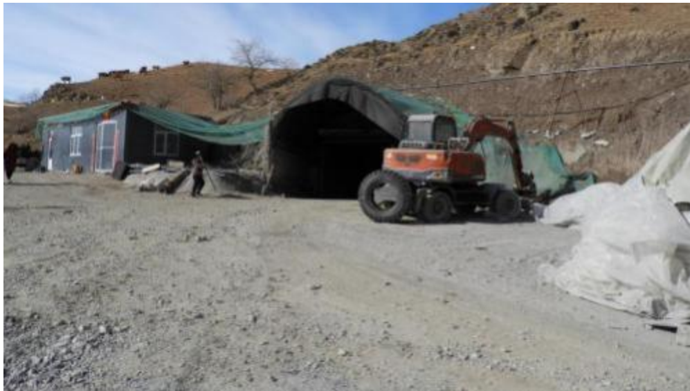
照片 3-11 斜坡道工业场地（局部）
