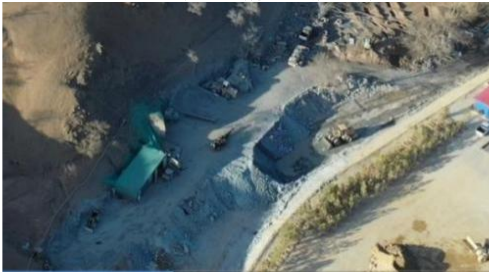
照片 3-12 斜坡道工业场地（整体）
