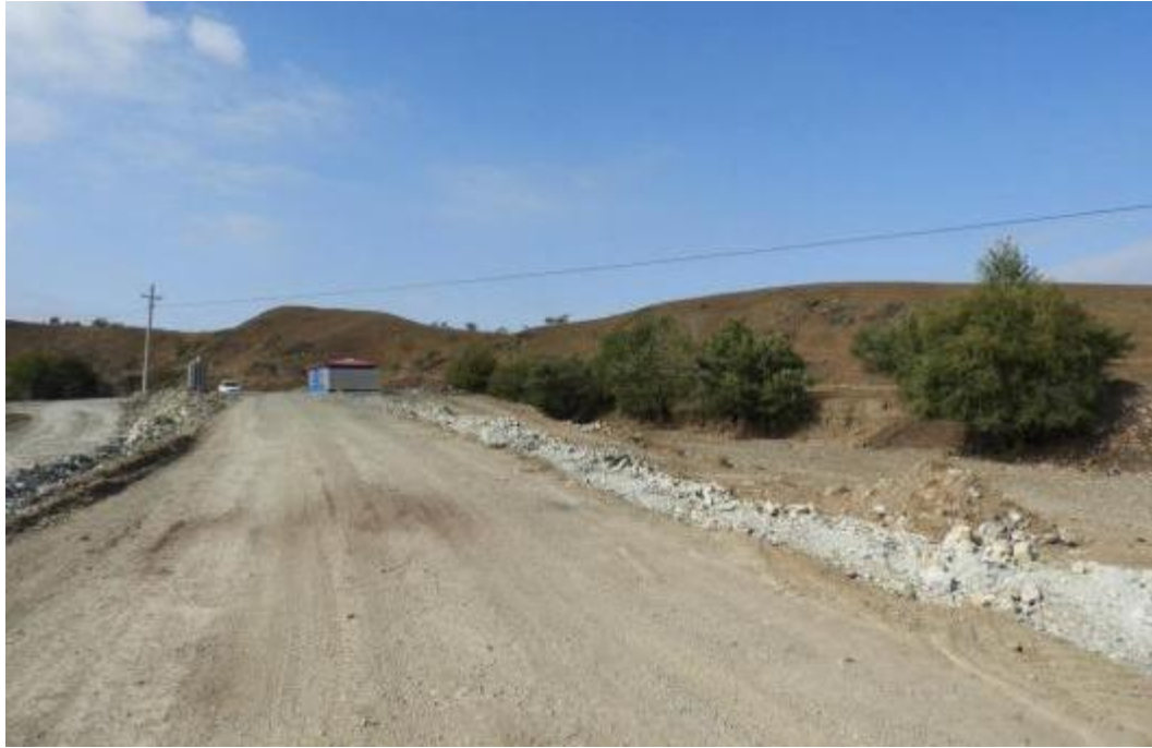
照片 3-45 矿区道路
