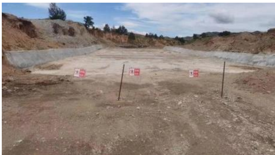
照片 2-38 3 号塌陷坑（治理后）
