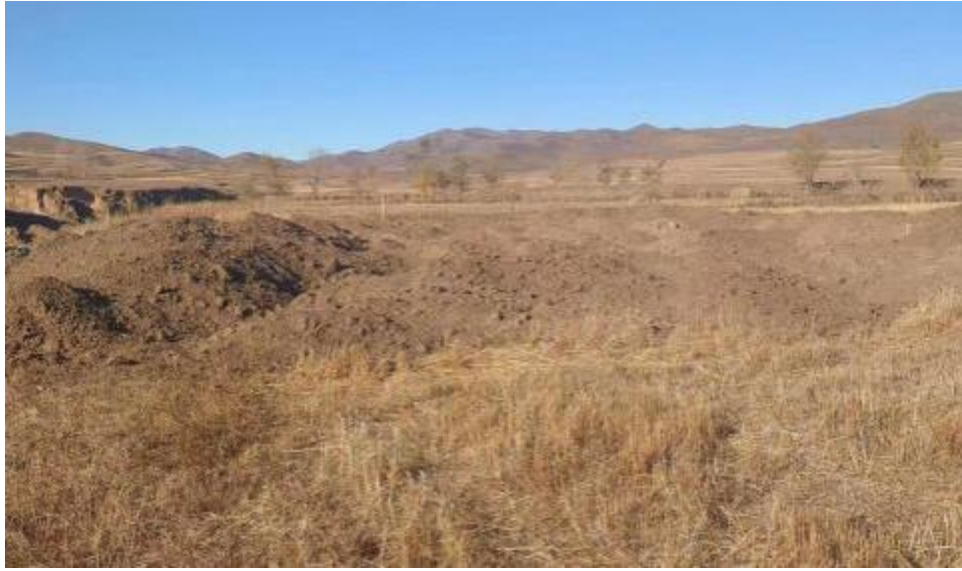
照片 2-39 4 号塌陷坑（治理后）
