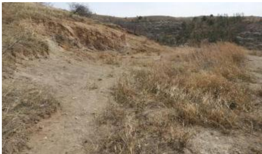
照片 4-1 钻机平台
