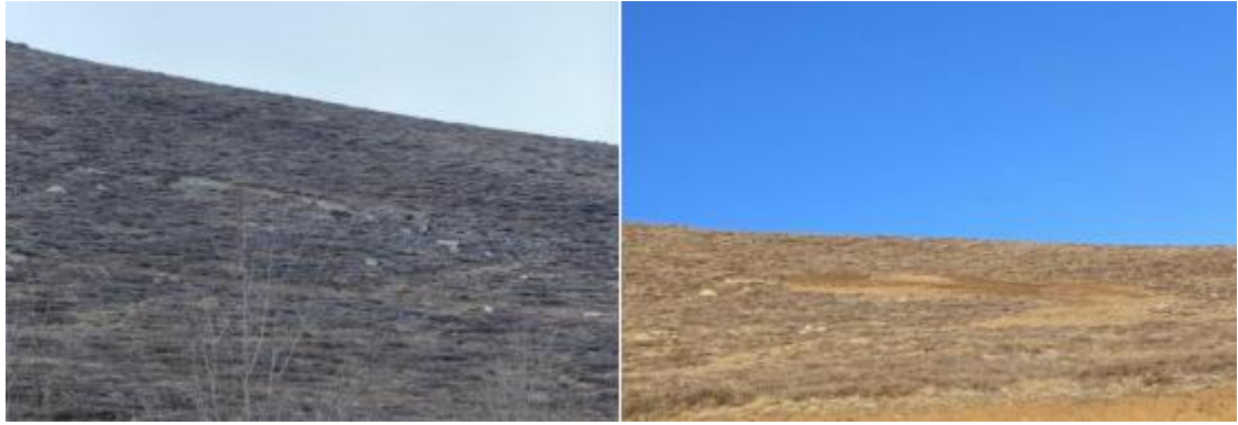
照片 2-3 PD1 治理前后（左：治理前；右：治理后）
