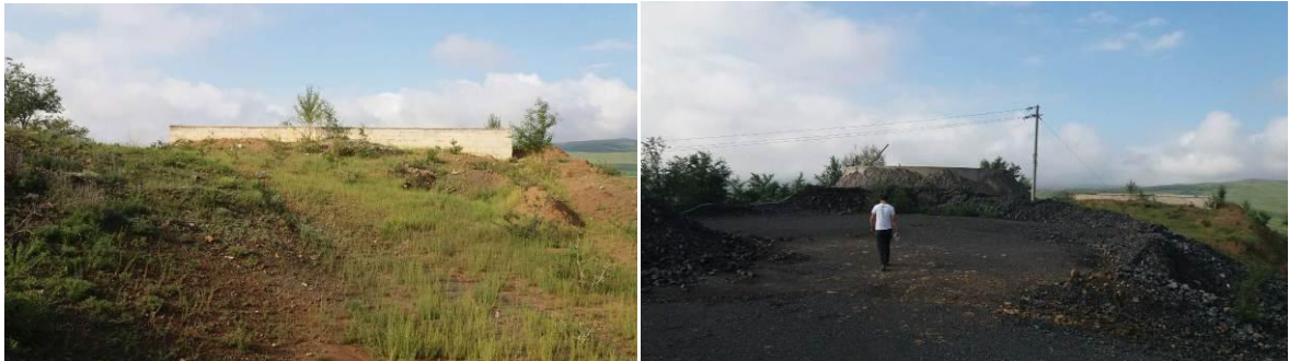
照片 17 高位水池
