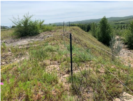
照片 1 尾矿库南部尾矿坝平台
