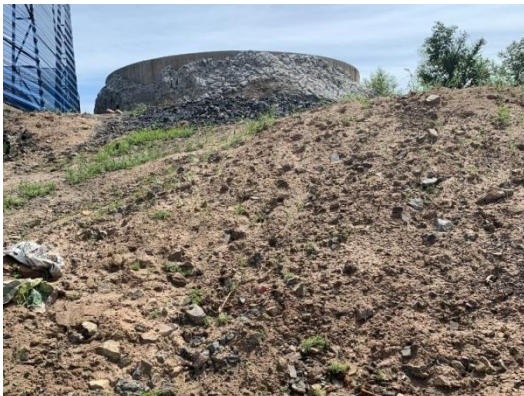
照片 3 高位水池
