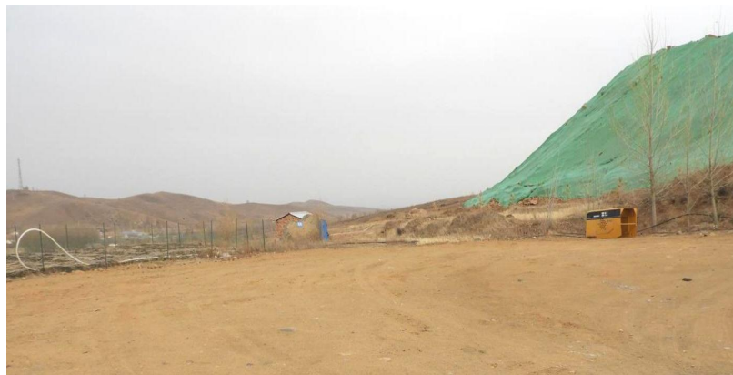
照片 3-19 办公生活区南东侧围挡
