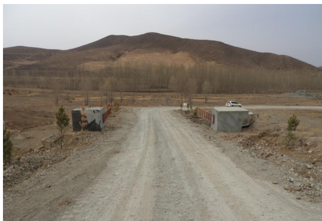
照片 3-20 矿区道路
