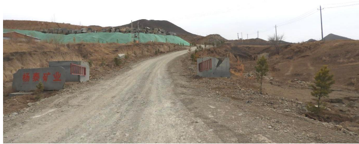
照片 3-8 1#表土存放场远景
