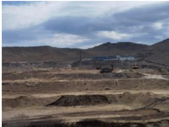
照片9 选矿厂、尾矿库（建设中）
