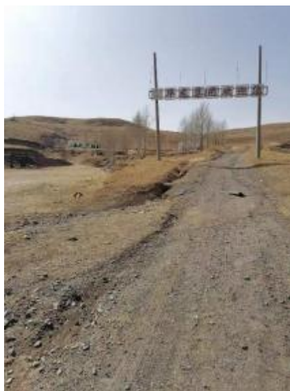
照片 18 矿区道路
