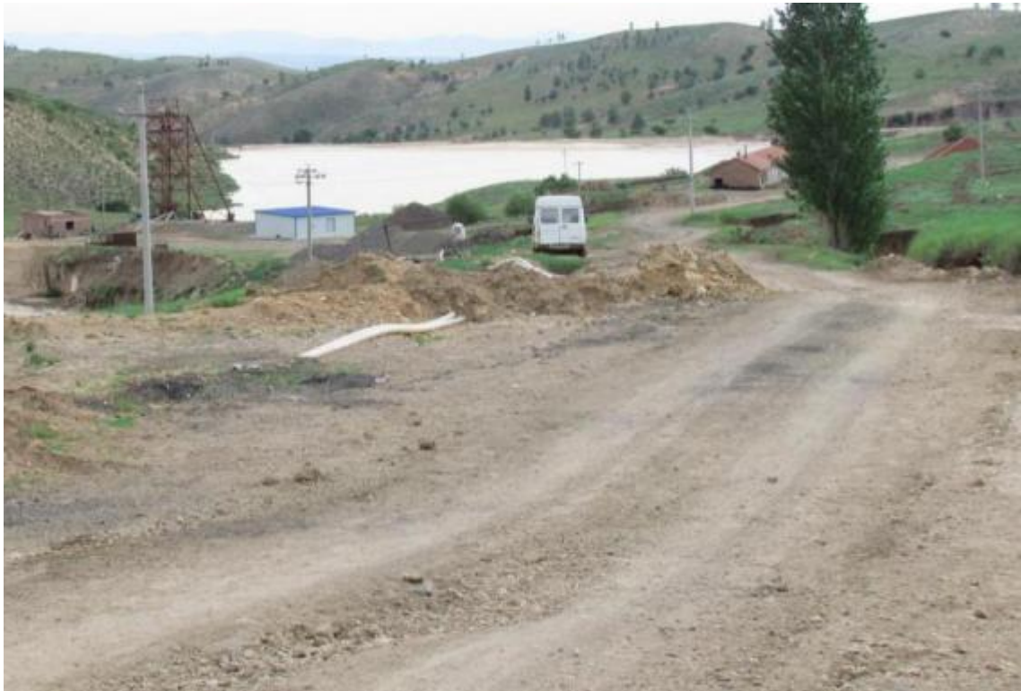
照片 4-8 矿区道路
