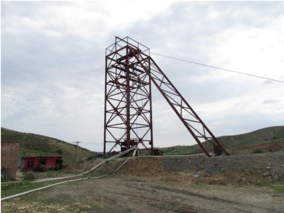
照片 4-1 竖井工业场地
