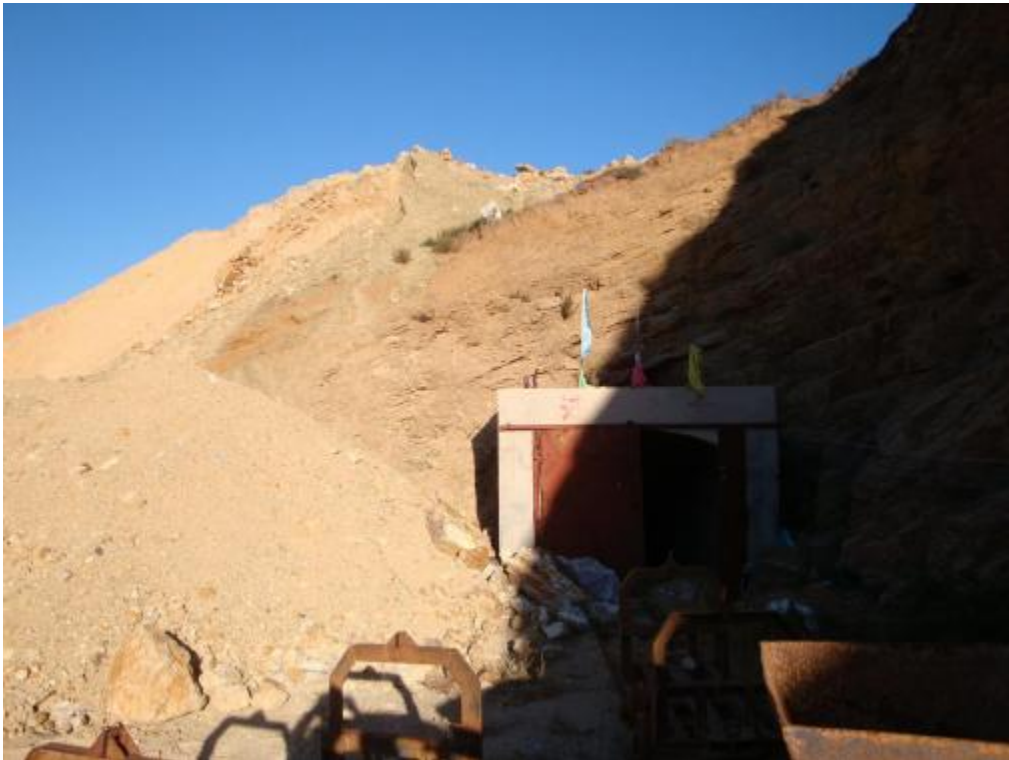
照片 4-2 斜井工业场地
