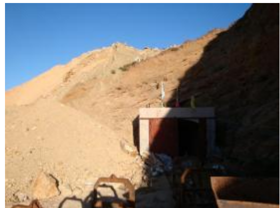
照片 2-4 斜井井口周边人工切坡
