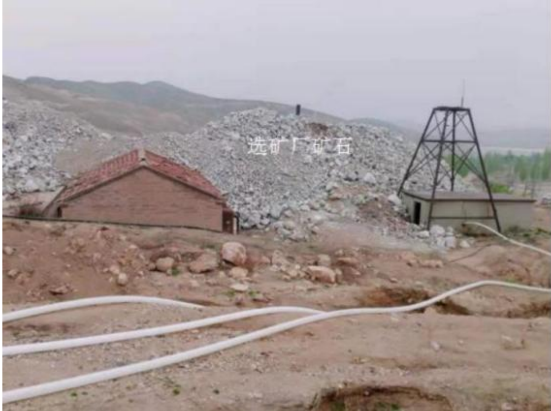
照片4-8 风井工业场地
