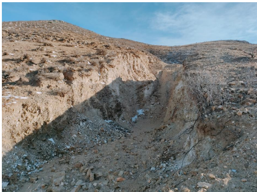
照片 2-6 剥离坑（本方案探槽）治理效果
