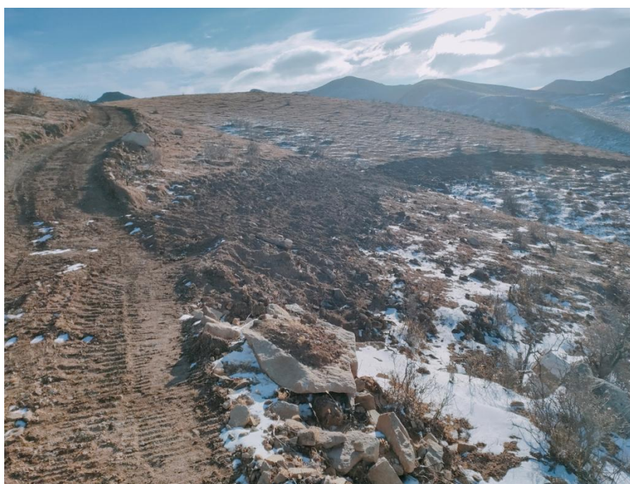
照片 4-2 矿区道路
