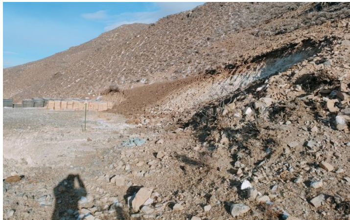
照片 2-4 SJ1 工业场地边坡治理效果
