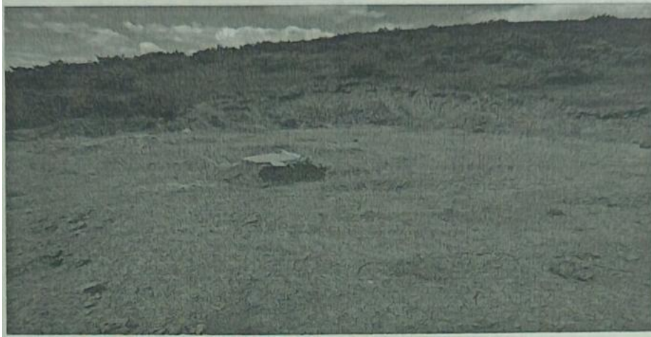
照片4-7 钻机平台
