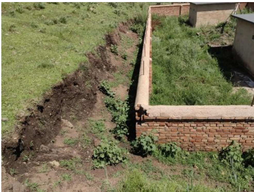
照片 3-4 **库及值班室切坡处
