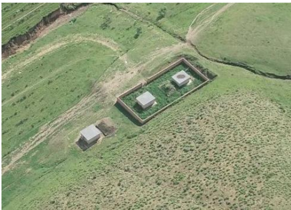
照片 3-5 **库及值班室俯视照片
