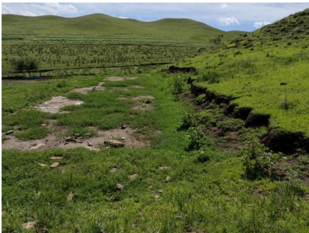
照片 3-9 西侧废弃建筑基础及切坡
