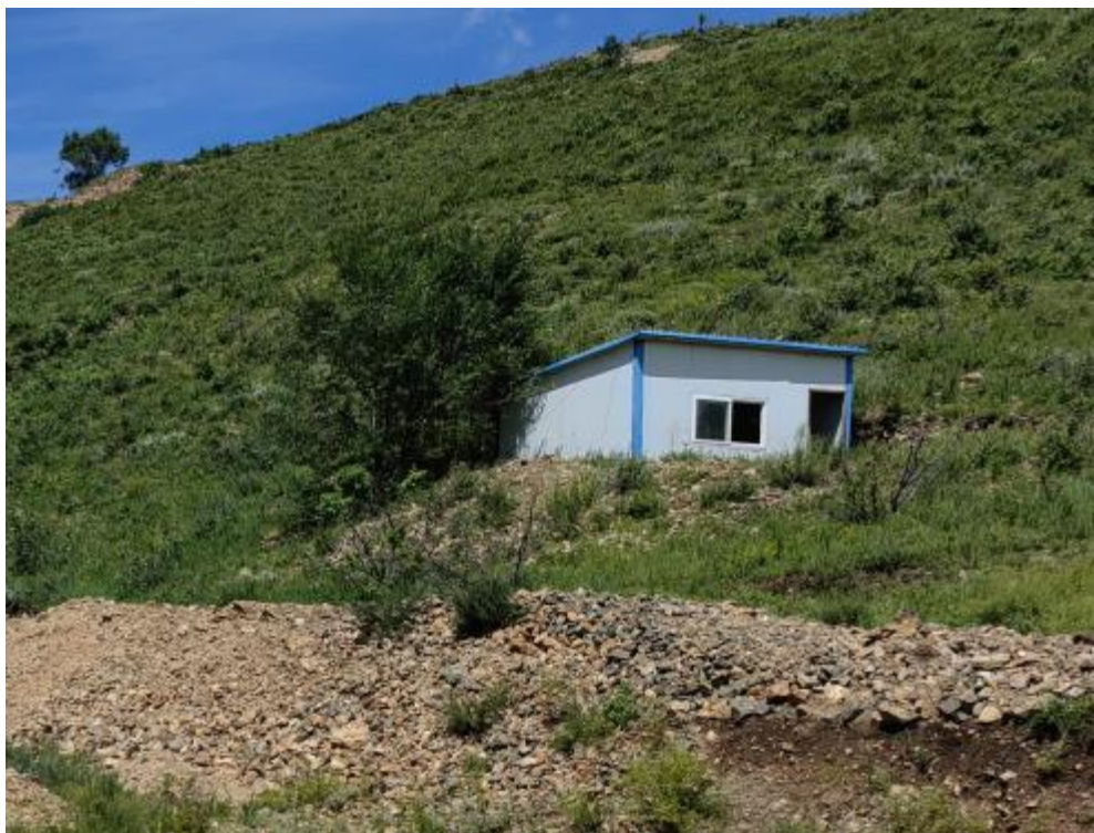
照片 3-8 配电室堆坡处
