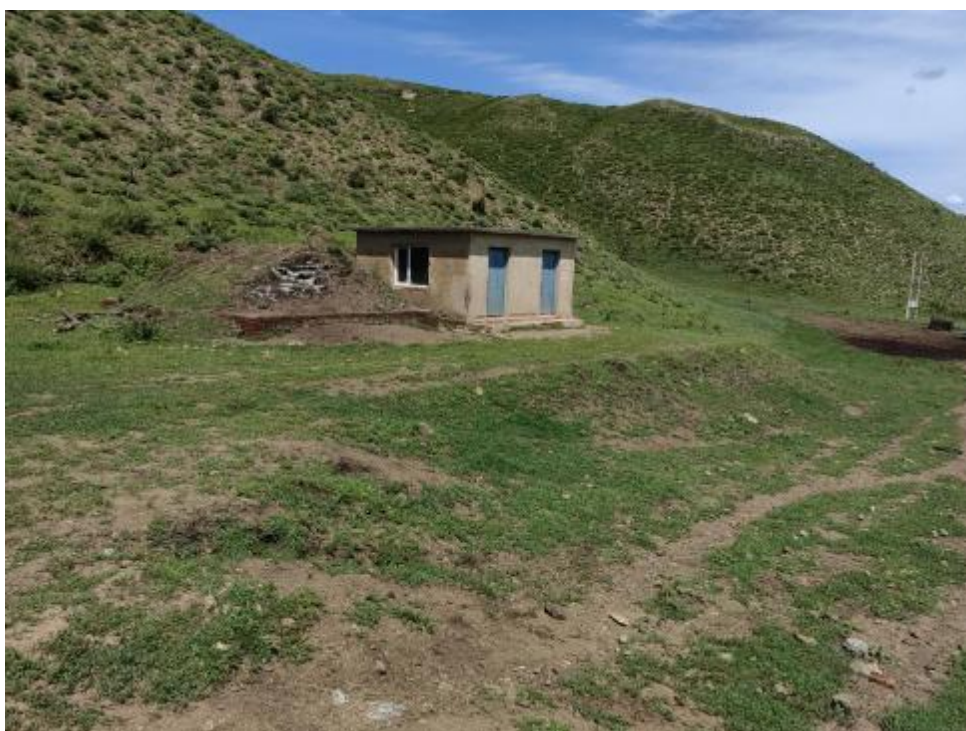
照片 3-3 值班室、防爆墙及前缘堆坡
