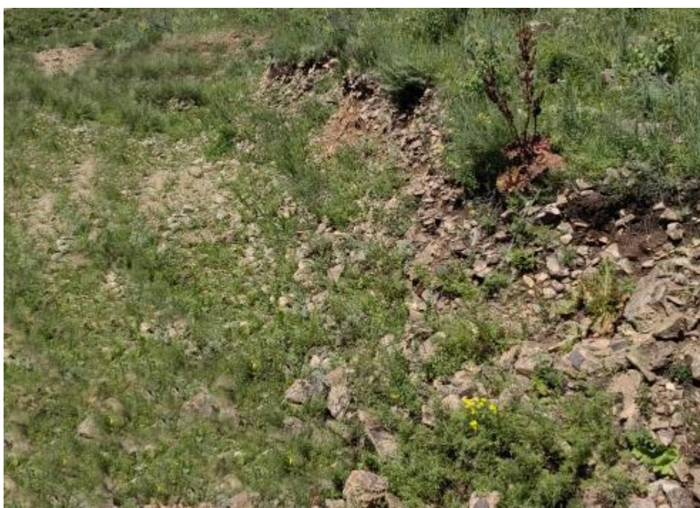
照片 3-10 东侧废弃建筑基础及切坡
