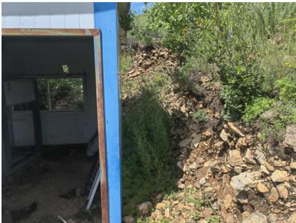
照片 3-7 配电室切坡处
