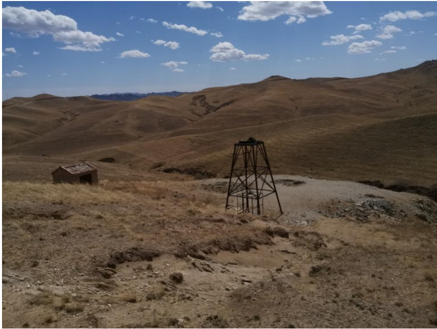
照片 4-2 二采区采矿工业场地现状
