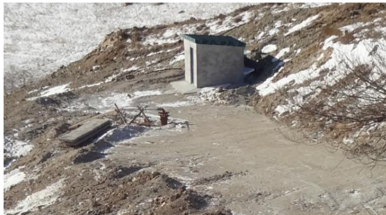
照片 4-11 高位水池
