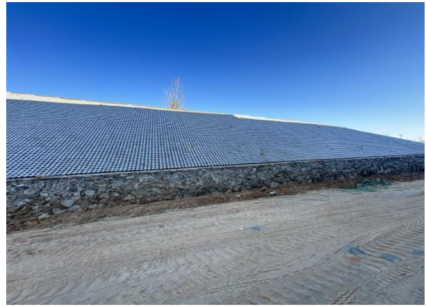
选矿厂东侧治理后
