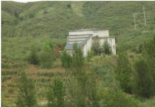
图 6 风井（FJ1）工业场地及堆坡
