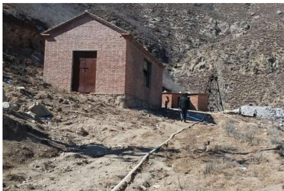
照片 4-1 1 号工业场地竖井
