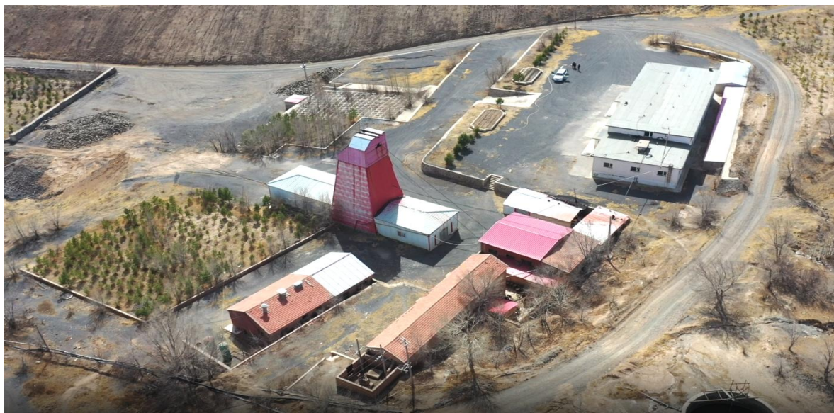
图 2 竖井工业场地航拍影像全貌
