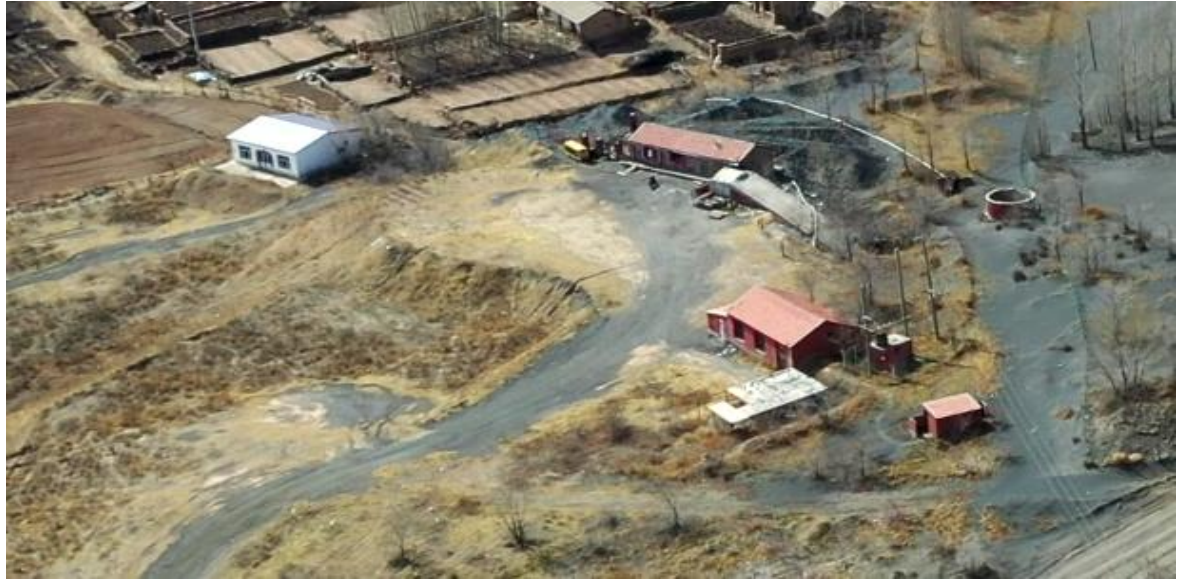
图4 官地斜井工业场地航拍影像全貌
