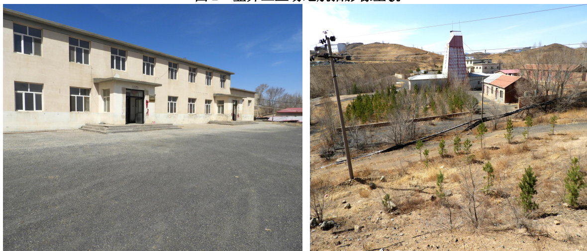
图 3 办公楼和竖井近景
