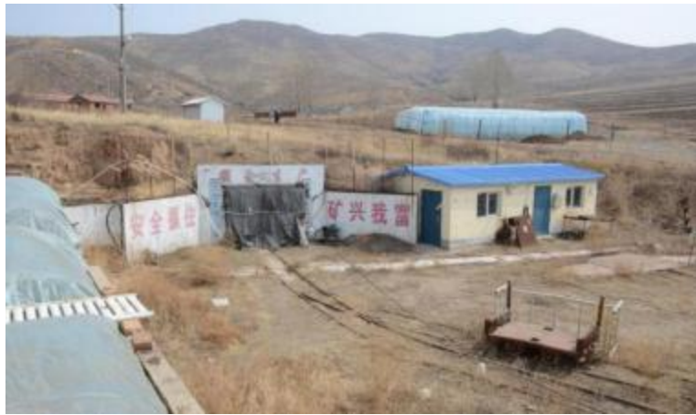
照片 4-3 斜井工业场地
