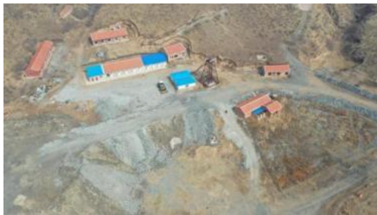
照片 4-2 通风竖井场地
