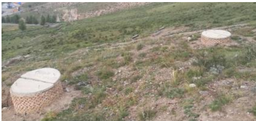
照片 4-7 高位水池
