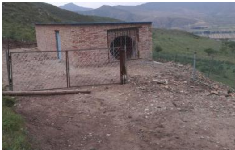
照片 4-4 回风井场地
