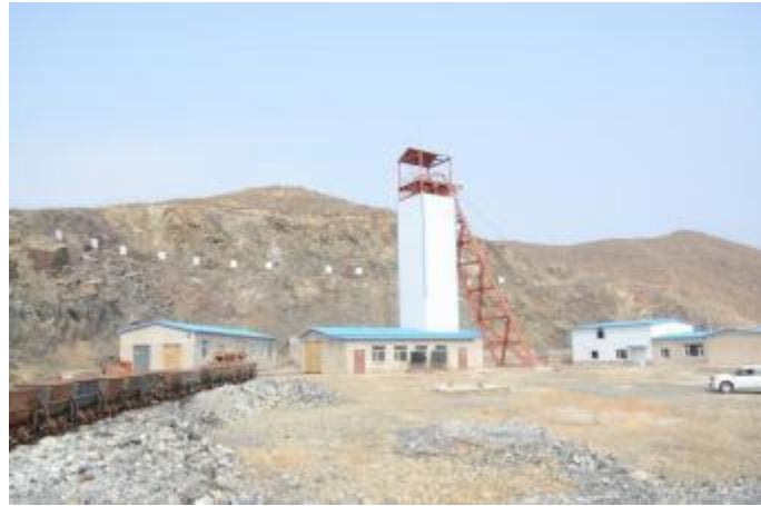
照片 4-1 竖井工业场地
