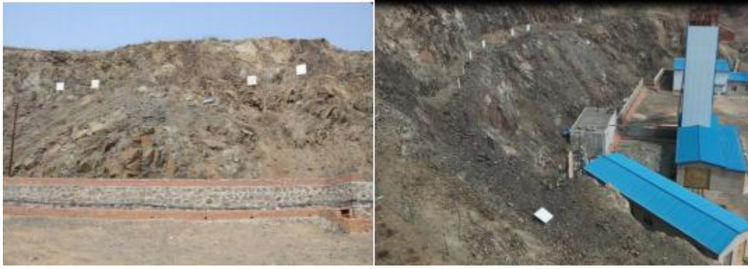
照片 4-15~4-16 竖井工业场地北部边坡
