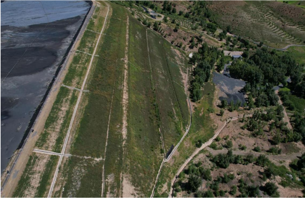
图 尾矿库坝面边坡治理
