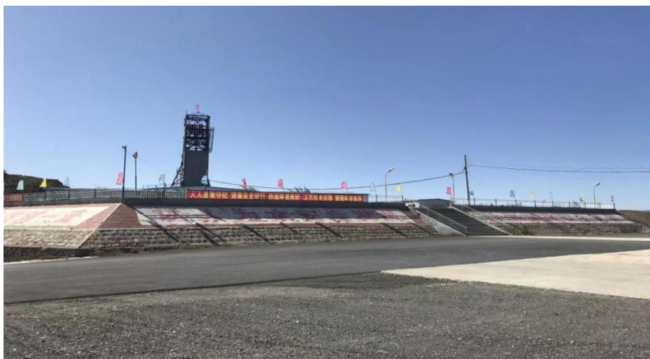
图 二采区北区采矿工业区
