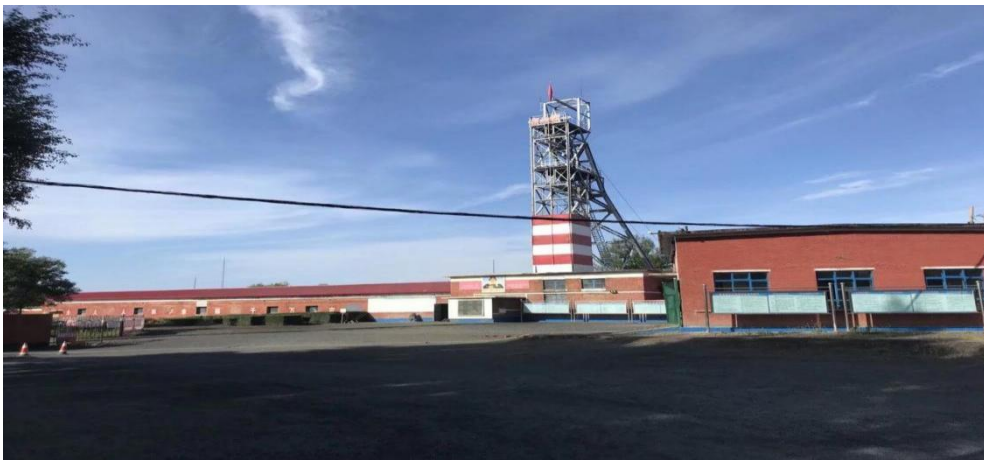
图 一采区采矿工业区
