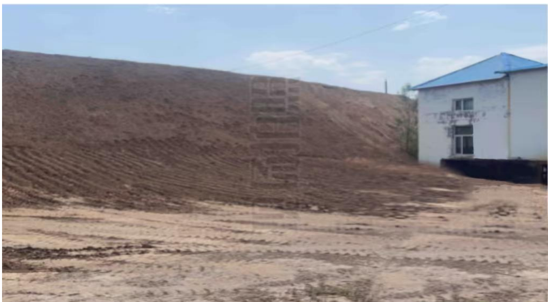
图 二采区北区原锅炉房北侧
