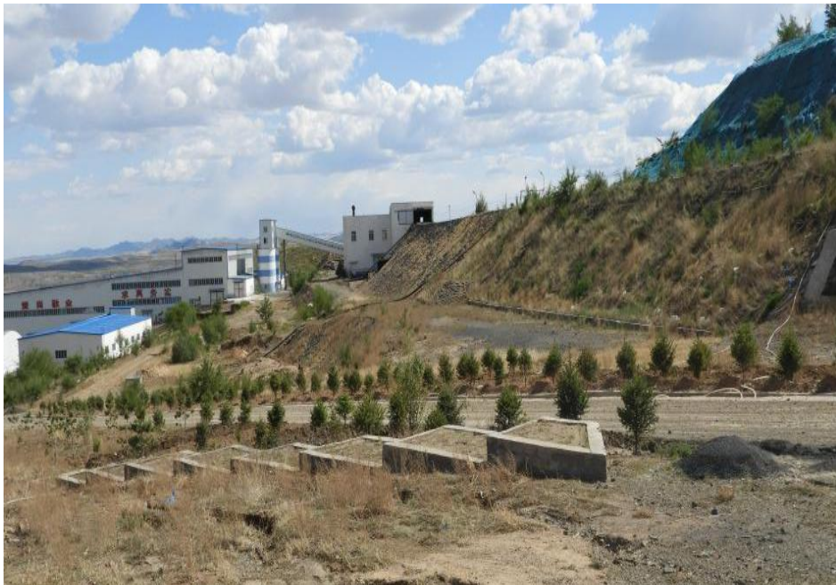
图 通往选矿二区矿区道路两侧绿化（自行治理）
