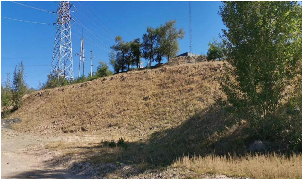
选矿一厂至一采区西侧边坡
