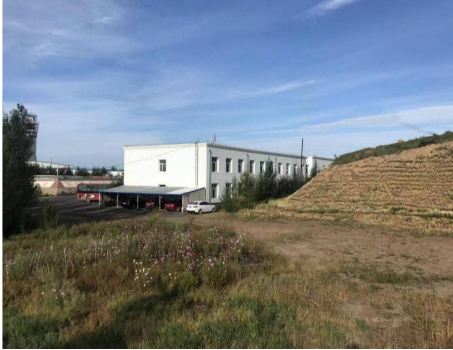
图 二采区北区办公生活区切坡
