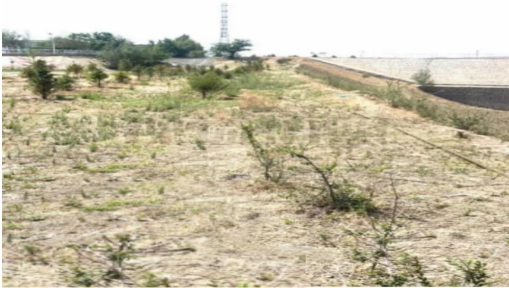
二采区废石场 4 两侧边坡顶部平台（①侧）
