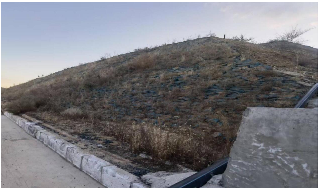
图 选矿二厂破碎工段南侧边坡
