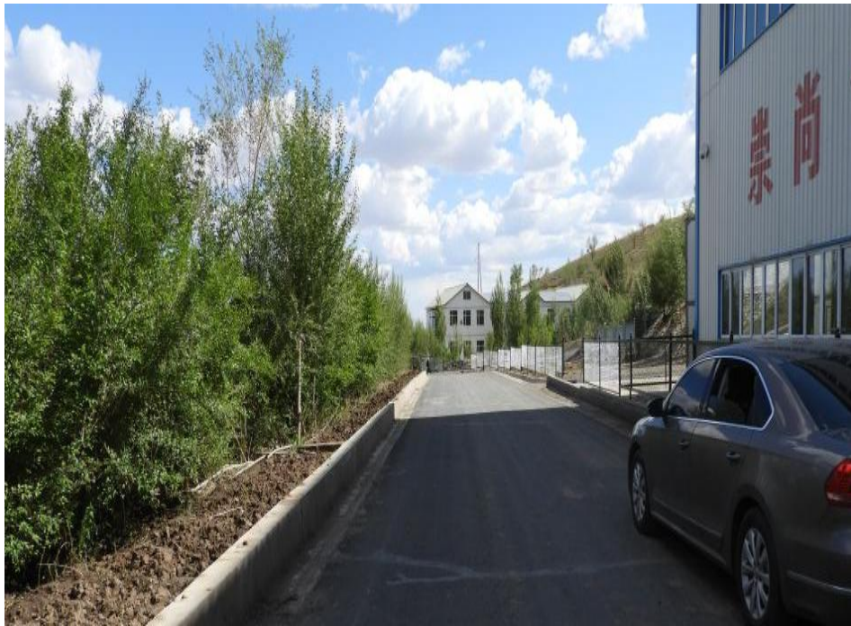
图 通往选矿二区矿区道路两侧绿化（自行治理）
