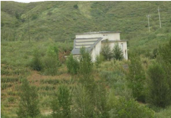
图 6 风井（FJ1）工业场地及堆坡
