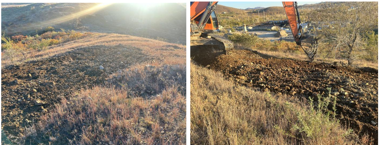
图2 探槽及钻机平台治理
