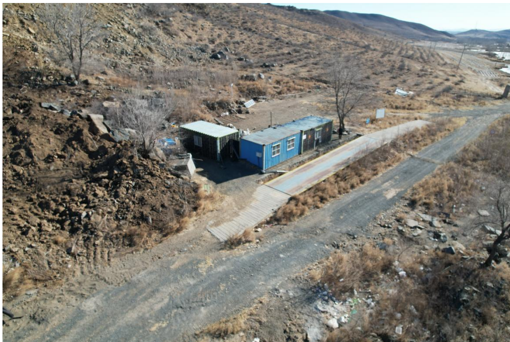
照片 4-9 矿区道路
