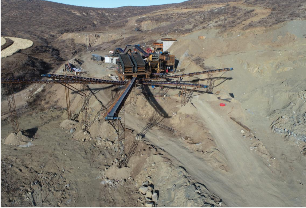
照片 4-5 碎石加工场地
