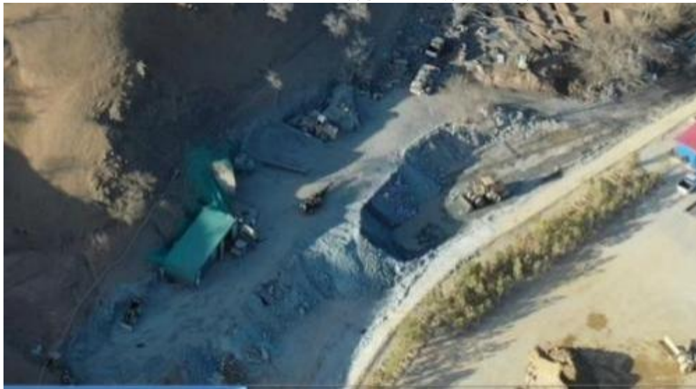
照片 3-12 斜坡道工业场地（整体）
