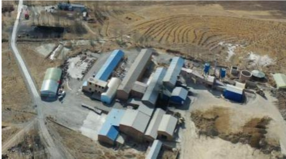
照片 3-42 选矿场（整体）
