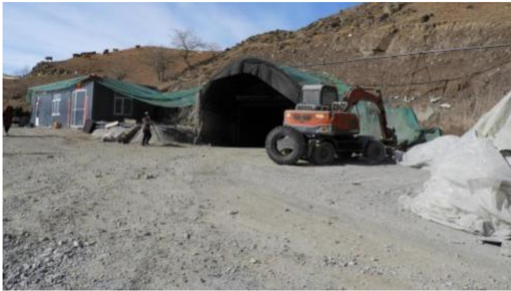
照片 3-11 斜坡道工业场地（局部）
