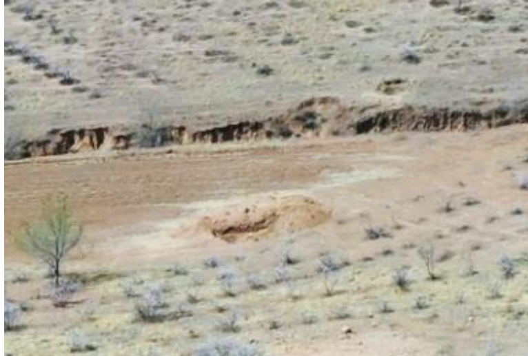
照片4-9 钻机平台蓄水坑
