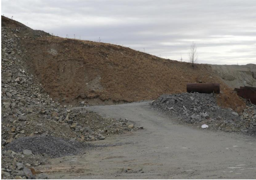
照片 4-4 露天采场超采区
