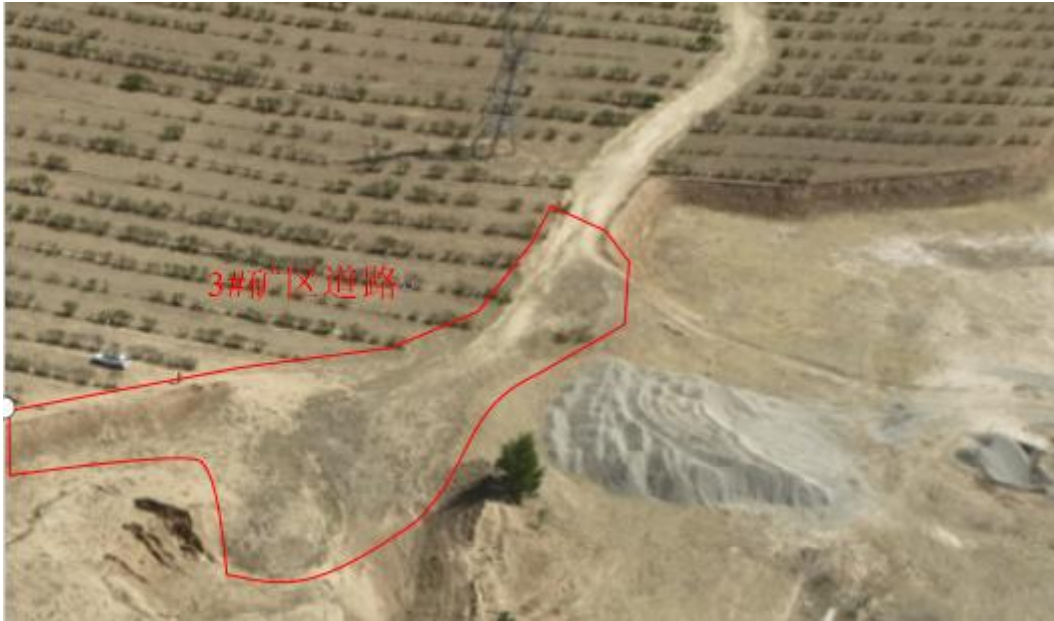
照片 4-12 3#矿区道路
