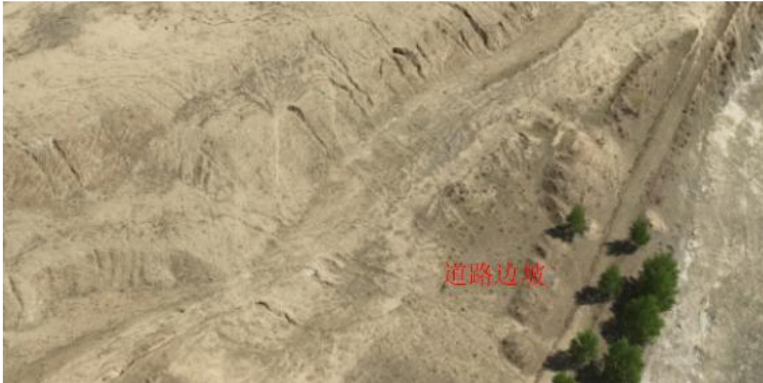
照片 4-10 道路边坡
