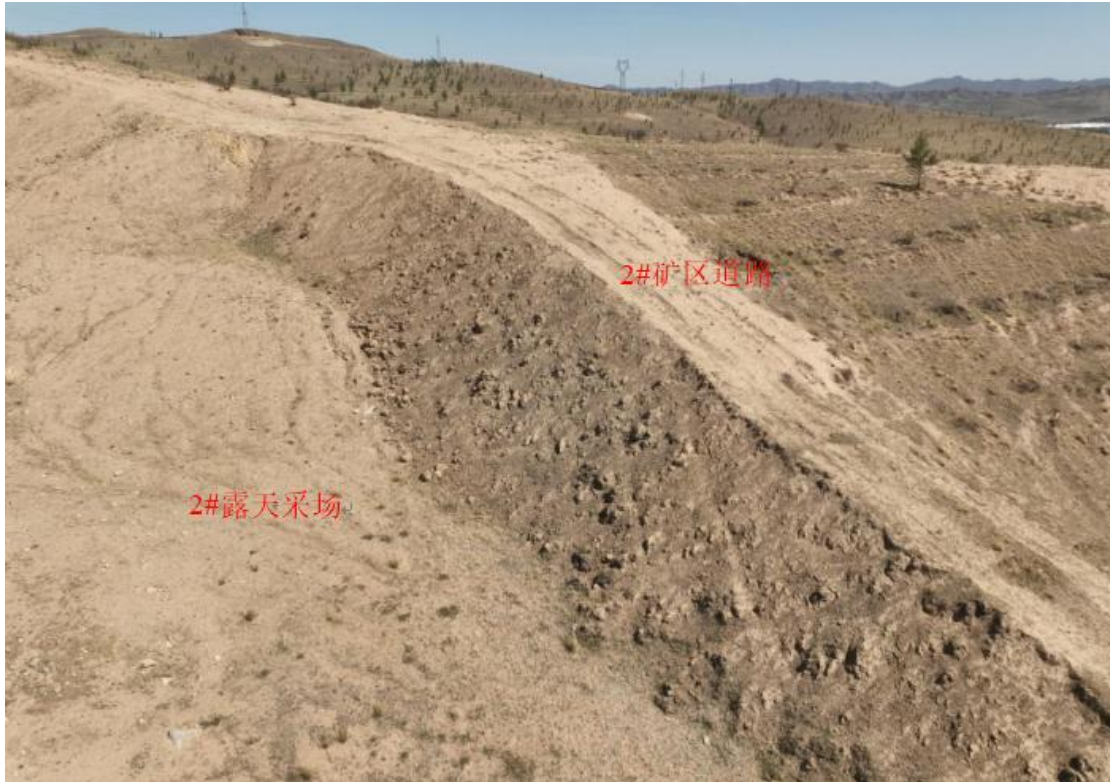
照片 4-8 2#矿区道路
