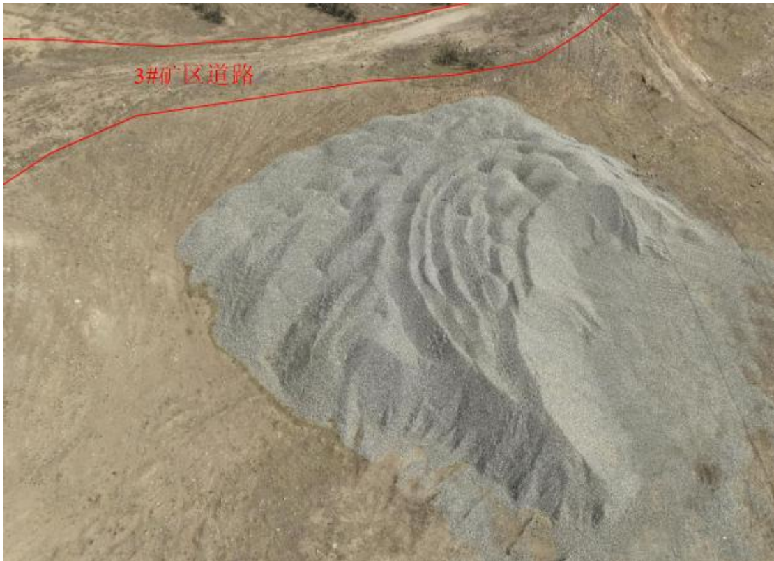
照片 4-13 料石堆放场
