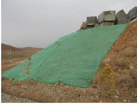
照片 3-7 1#表土存放场底层阶段边坡
