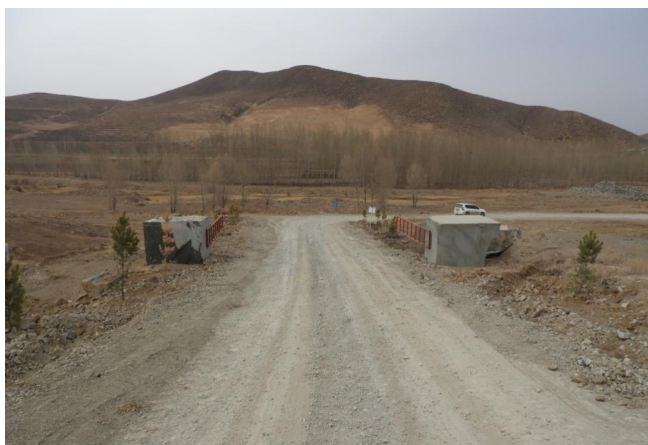
照片 3-20 矿区道路
