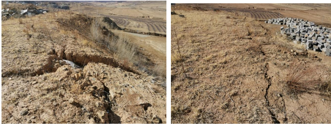
照片 3-1 1#表土存放场边坡处
