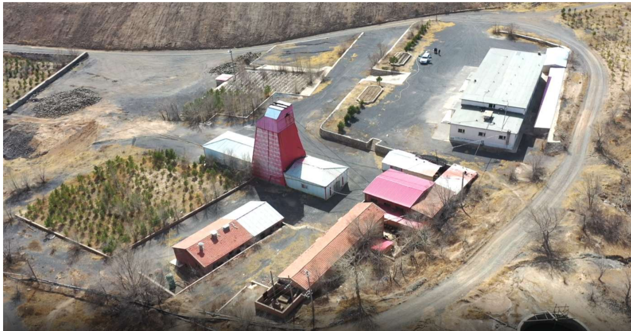
图 2 竖井工业场地航拍影像全貌
