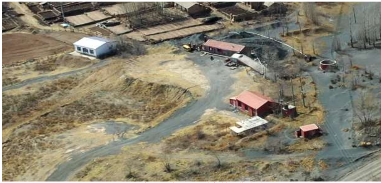
图4 官地斜井工业场地航拍影像全貌
