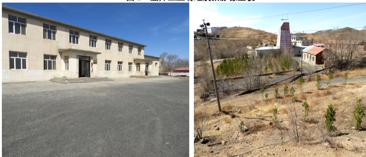
图 3 办公楼和竖井近景
